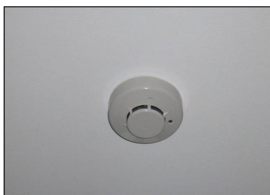
ภาพที่ 1-9 อุปกรณ์ตรวจจับความร้อนและอุปกรณ์ตรวจจับควัน
