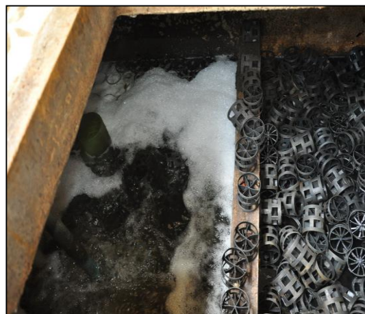
4.ระบบบำบัดน้ำเสียแบบเติมอากาศแบบมีตัวกลาง (บริเวณเรือนเพาะชำ)
